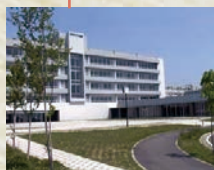
●L棟（大学院棟）
