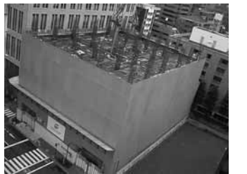
建て替え工事の様子
