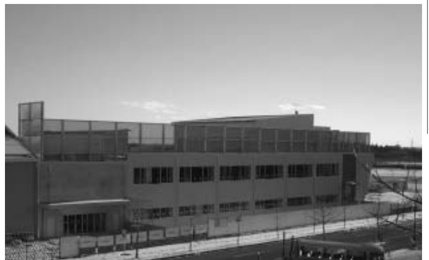
完成に向け工事は順調に進んでいる
