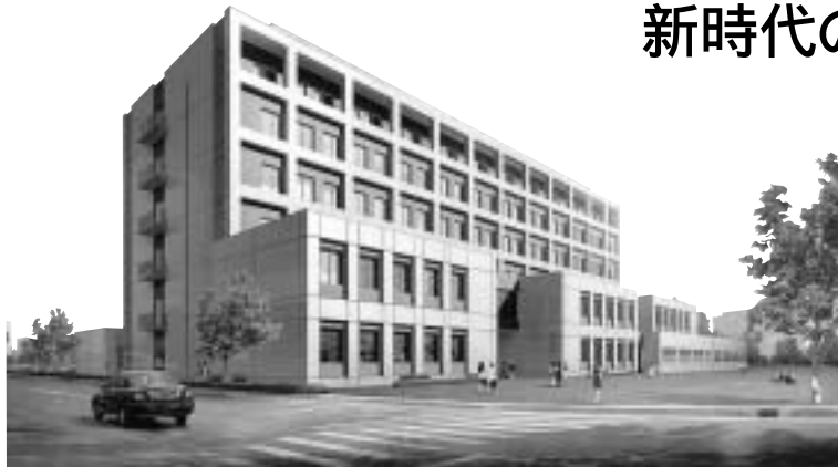
薬学部棟（平成17年2月完成予定）
