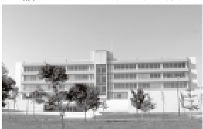
5階建ての大学院棟。各種研究室が備わっています。
