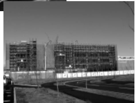
現在建設中の大学院棟（L棟）
