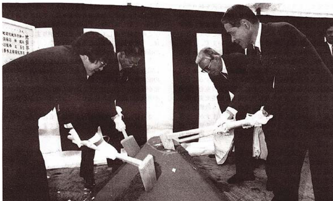
新学部増設へ。医療福祉学部開設に伴う校舎等増設工事の起工式でくわ入れする、(写真左より)高木邦裕理事長、大谷藤郎学長、宮地貴一副理事長、幸田正孝・国際医療福祉総合研究所所長予定者=平成7年12月20日(記事は2、4ページ)
