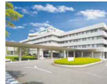
国際医療福祉大学塩谷病院 (栃木県矢板市)
